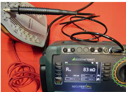
Bild 4: Messung mit Bestätigung, dass der Schutzleiter angeschlossen ist
