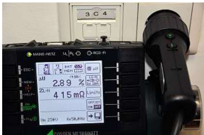
Bild 80: Ergebnis einer Messung zum Spannungsfall
