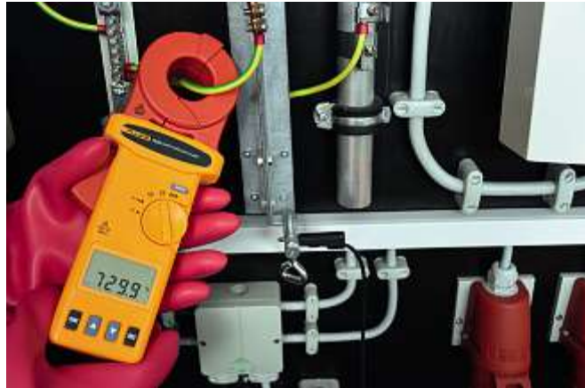
Bild 78: Einsatz einer kombinierten Messzange mit einem zu erwartenden Messwert von 729,9Ω
