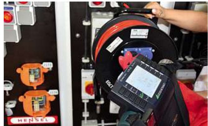
Bild 70: Wechselstromsensitive Messungen bei zusätzlicher Leitungslänge
