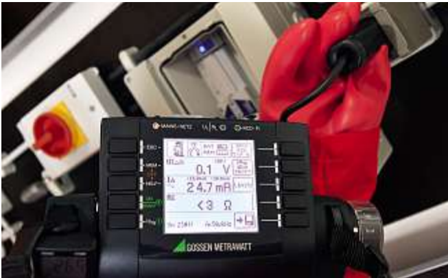
Bild 69: Wechselstromsensitive Messung mit einem zu erwartenden Messwert für I_{\Delta} von 24,7 mA
