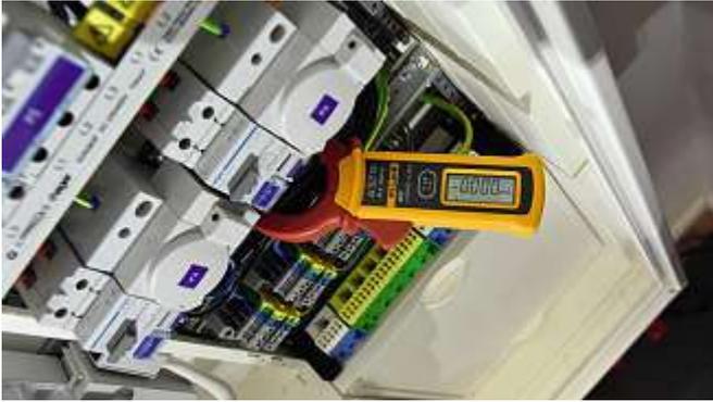
**Bild 60:** Ableitstrom der verteilerinternen Steckdose mit 0,000 mA
