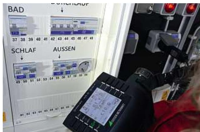
**Bild 59:** Wechselstromsensitive Messung mit einem zu erwartenden Messwert für  $I_{\Delta}$  von 7,8 mA
