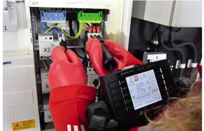
**Bild 65:** Ermittlung des möglichen Kurzschlussstromes eingangsseitig am LSS mit 170A
