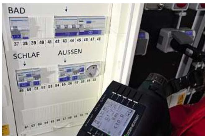
**Bild 58:** Wechselstromsensitive Messung mit einem zu erwartenden Messwert für  $t_a$  von 8 ms
