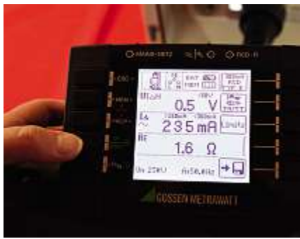
Bild 46: Wechselstromsensitive Messung mit einem zu erwartenden Messwert für I_A von 235 mA
