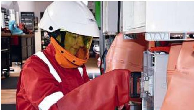
**Bild 25:** Einsetzen der NH-Sicherungen
