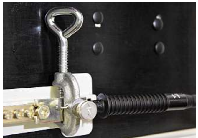
Bild 18: Zentraler Messpunkt mit Verwendung einer PE-Prüfklemme
