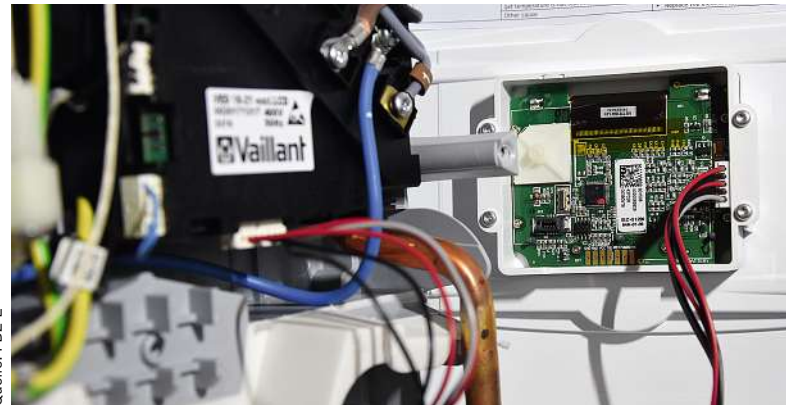
Bild 16: Geöffneter und mit Elektronik versehener Durchlauferhitzer
