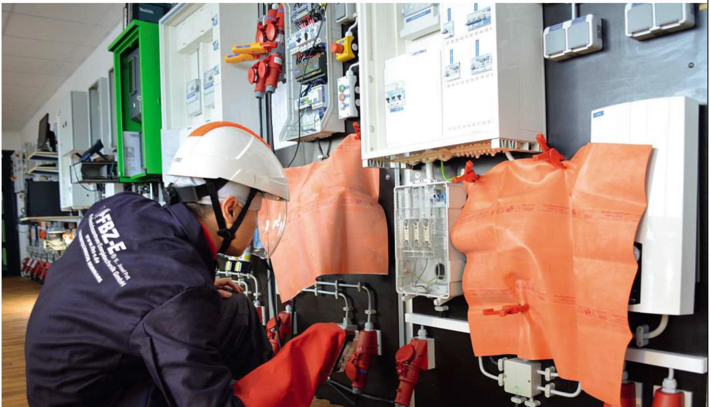
Am Fachbereichszentrum Energietechnik (FBZ-E) in Leer: Ein Seminarteilnehmer stellt mit gewissenhaftem Blick die korrekte Position der eingesetzten NH-Sicherungen fest
