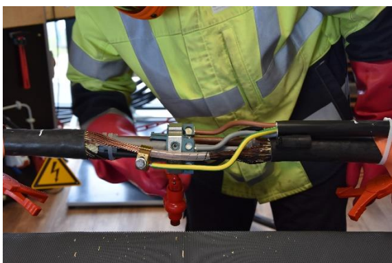
Montage einer Abzweigmuffe geschirmt
