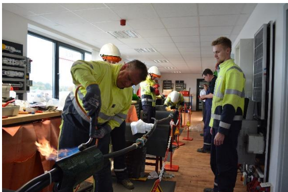
Montage einer Abzweigmuffe geschirmt
