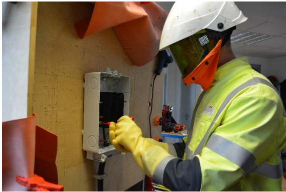
Einbau/Ausbau von Schaltleisten
