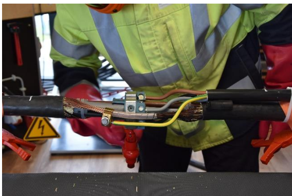
Montage einer Abzweigmuffe geschirmt
